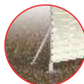
5. Parafusar os painéis metálicos aos montantes. Utilizar autobrocante.
