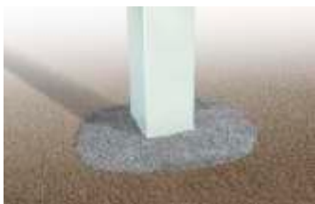
4. Após aprumado e alinhado, concretar a base.
