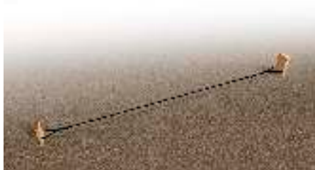
1. Definir o alinhamento do tapume. Espaçamento 2,16m.
